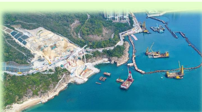
將軍澳隧道入口的土地平整工程及 將軍澳灣填海工程進行中 Site formation of Tseung Kwan O Portal and reclamation works at Tseung Kwan O Bay in progress
