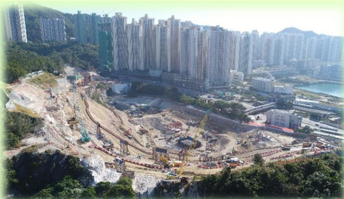
藍田交匯處的土地平整進行中 Site formation at Lam Tin Interchange in progress
