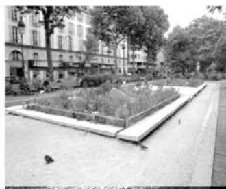
图2 圣马丁水道暗河段穹顶及圆形采光窗
