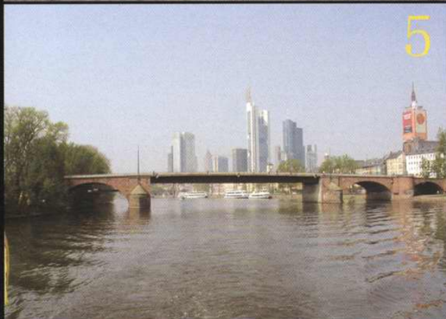
图5 德国某城市跨河桥（简支钢板加多孔拱桥的组合结构）
