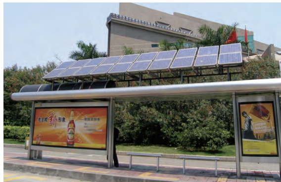
图5 深圳市某太阳能公交站台
