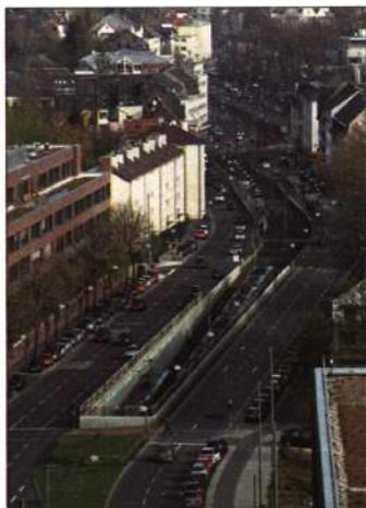
图3. 埃舍尔海默公路是进出法兰克福市中心的主干道，1962—67年开始建设该条大道下的轻轨线路，使得轻轨通过隧道进入市中心
