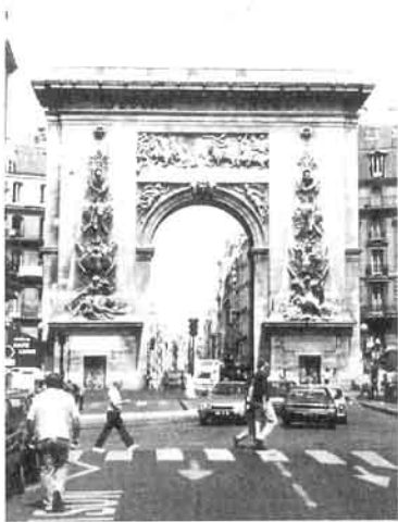
图12 巴黎圣·德尼门整治后的现状
