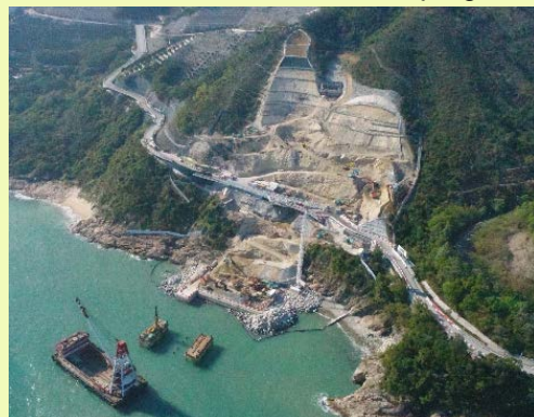
將軍澳隧道入口的土地平整進行中 Site formation for construction of TKO Portal in progress
