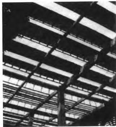
图1 屋顶太阳能和光伏遮阳板
