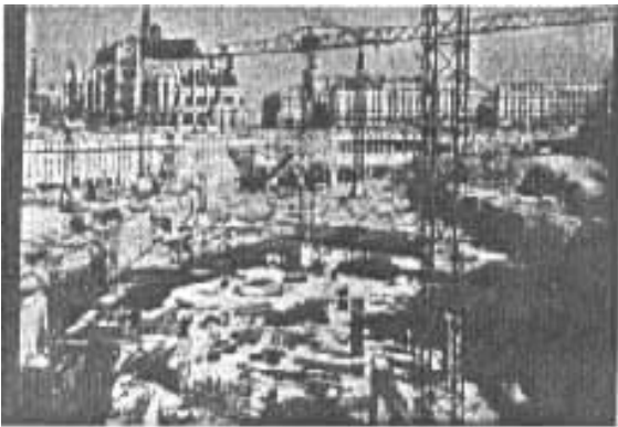
图2 建设中的 Les Halles 地区
