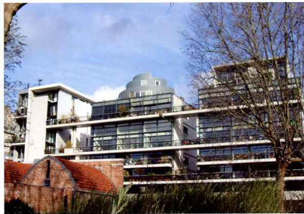
图4 贝西开发区公园旁的住宅, 由于开发区的规划是统一完成的, 经过了严格的程序审批, 作为法律性对单项工程有明确的要求, 虽然经历了很长的建设阶段, 并且不同的建筑由不同的建筑师设计, 个体建筑各不相同, 但建筑群体却达到了统一协调。
