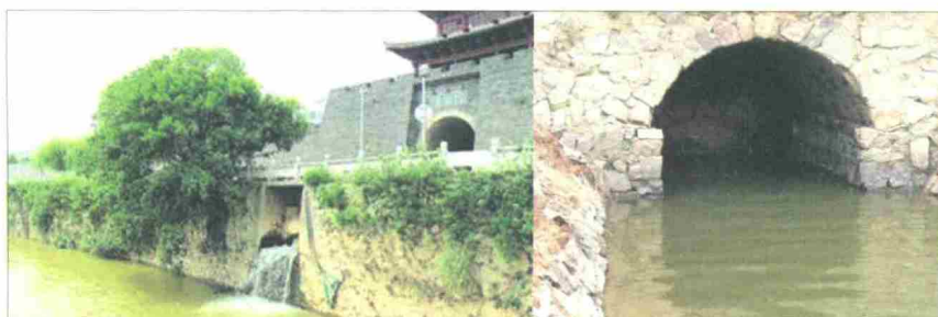
图5 现状“龟角尾”水窗和“水没洞”水窗
