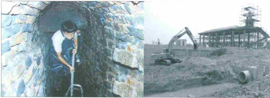
图8 福寿沟检查维护及建设中的建春排涝站
