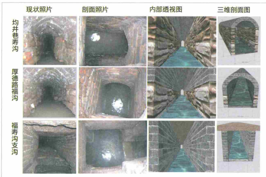
图3 福寿沟断面结构现状及复原图
