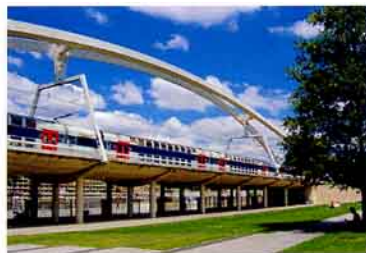
图8 RER（郊区快速铁路）高架桥
