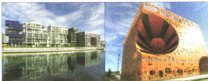
图6 里昂汇流区建筑实景 Fig.6 Buildings in Lyon Confluence 资料来源：笔者拍摄。
