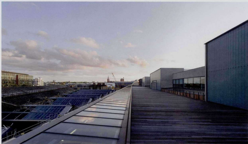
2 新建建筑屋顶平台与老建筑相连
