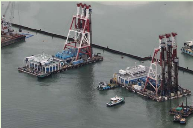
深層水泥拌合法工程（進行中） Deep cement mixing works (in progress)
