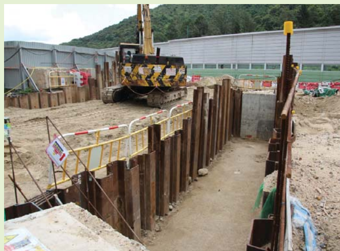
東涌第58區 - 興建中的基建設施 Tung Chung Area 58 - infrastructure works in progress
