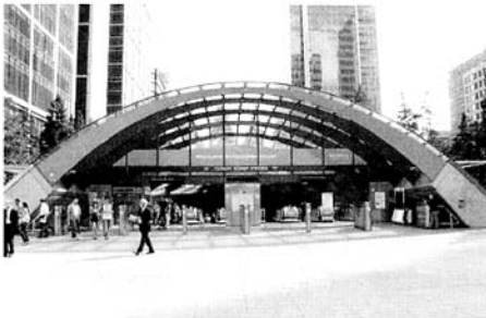
图 2 地铁朱比利线加那利码头站出入口实景图
