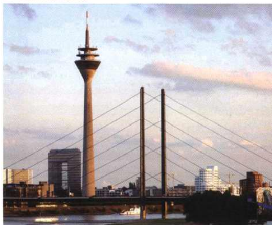
图9 德国莱茵之膝大桥
