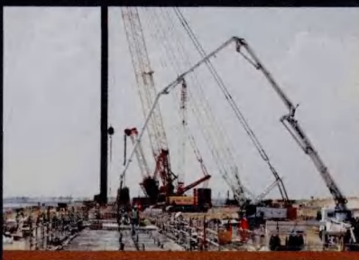
正在修建的码头隔离墙
