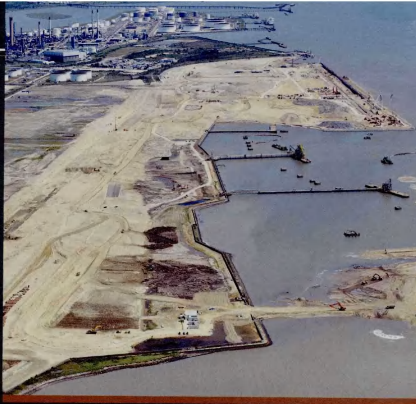
正在修建的伦敦门户港
