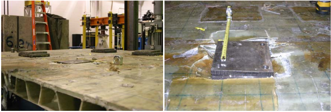
a. HFRPC deck surface
