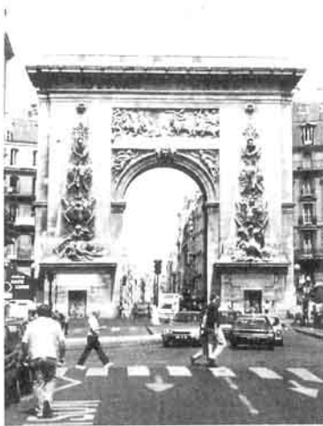
图12 巴黎圣·德尼门整治后的现状
