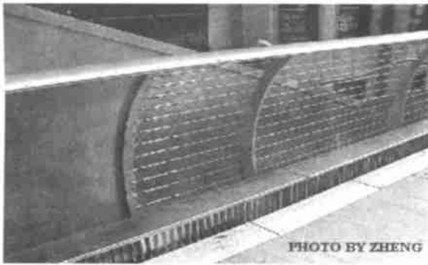
图6 桥面、风嘴和栏杆
