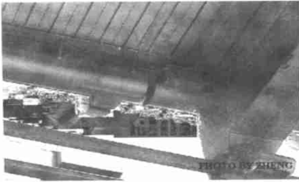
图5 横梁、纵梁和桥面板连接
