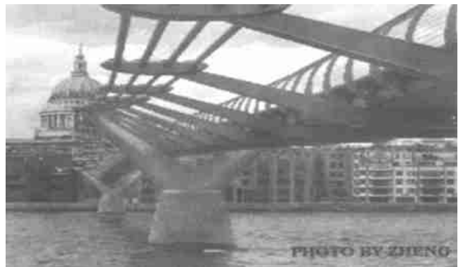
图4 主缆、横梁和桥塔
