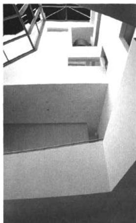
图17 南侧的“内立面”
