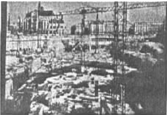
图2 建设中的 Les Halles 地区
