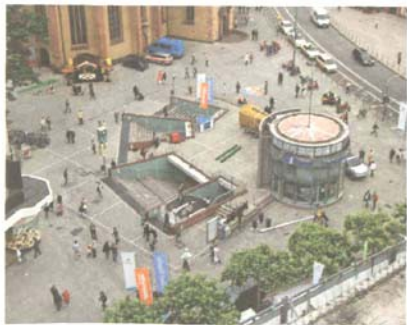
图 6 蔡尔街 (Zeil) 末端通向地下轨道交通 (U 和 S-Bahn) 车站的通道入口，法兰克福
