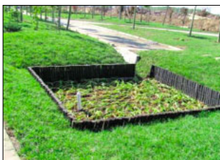
图28 雨水花园 Fig.28 Rainwater garden
