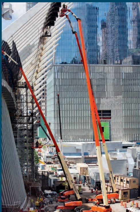
捷尔杰1850SJ高空作业平台现场施工
