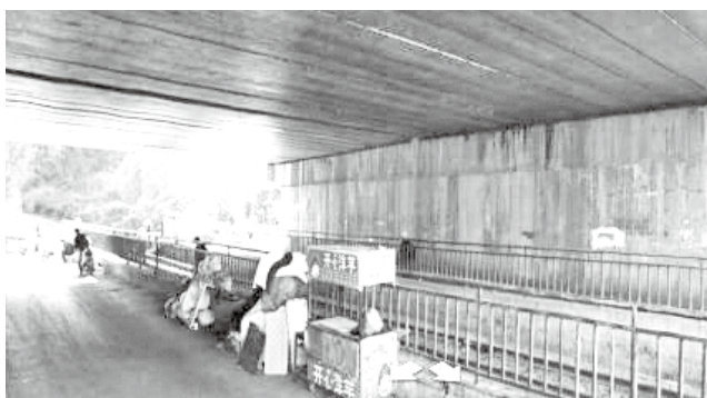
图4 高架桥下的残余空间(图片来源: 作者自摄)
